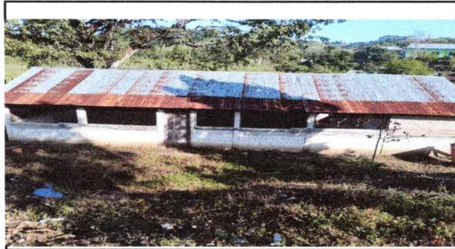
Foto1: CAMBIO DE LAMINAS YA QUE ESTAN DETERIORADO
